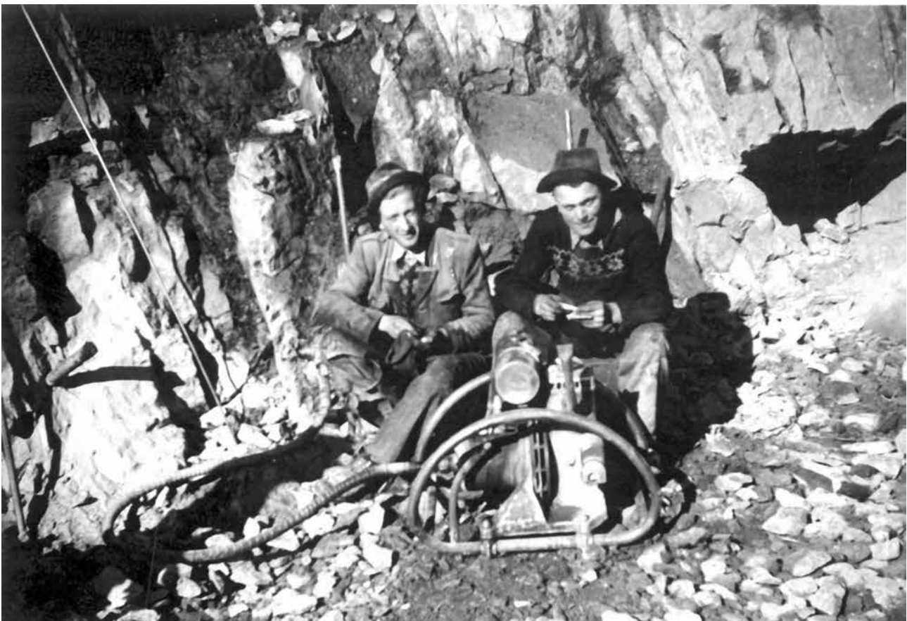
Abb. 1: Straßenbauarbeiten im Wölfnitzgraben, um 1950
