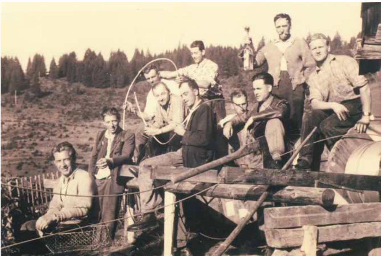
Abb. 14: Holzarbeiter aus dem Revier Saualpe beim Verlegen der E-Leitung
